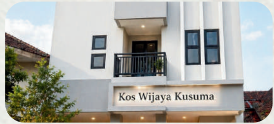
Kos Wijaya Kusuma, Jakarta - Bangunan kos 4 lantai yang dikelola sebagai aset hunian sewa perkotaan, memperkuat pengalaman grup dalam manajemen properti harian dan pengelolaan aset produktif.
